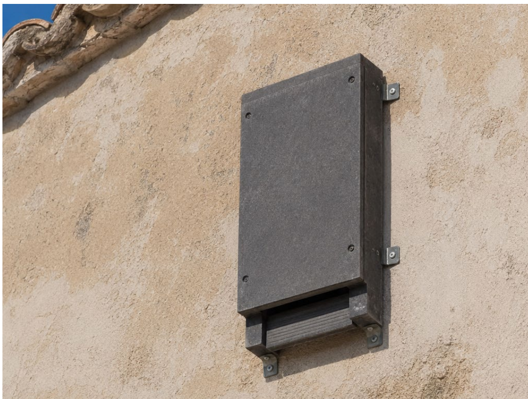
Figura 3 – Esempio indicativo di bat box in woodcrete fissata su parete intonacata di un fabbricato esistente.
