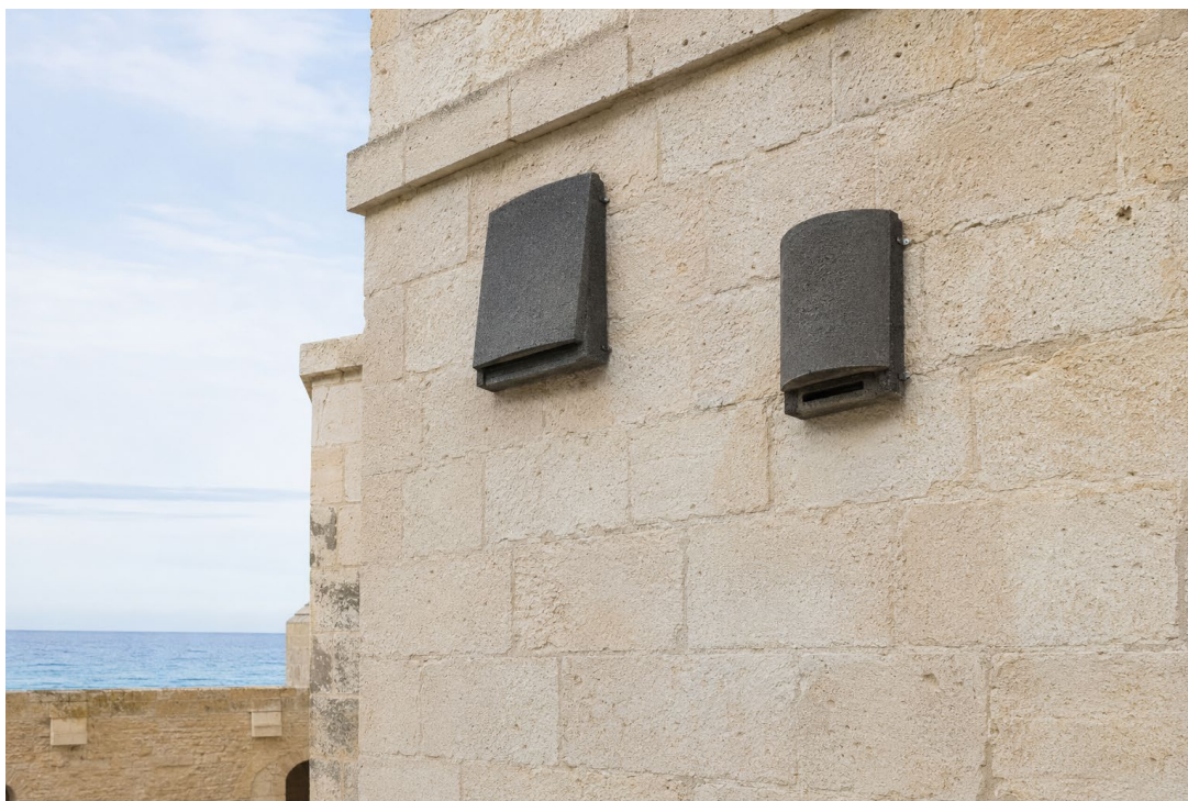
Figura 2 – Esempio indicativo di installazione multipla di bat box su una parete in muratura, in posizione elevata e con traiettoria di volo libera.
